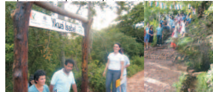
Obras de infraestructura de mejoramiento al acceso y Ycuá Rosa Isabel
